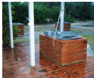
*Fotografía 1 Sistema de canaletas de captación con un registro para la cosecha en un hogar (Extraída de Sistemas de Captación y Almacenamiento de Agua en el Chaco Central.)*
